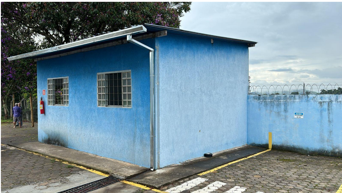
Figura 4 - vista de um bloco externo existente
