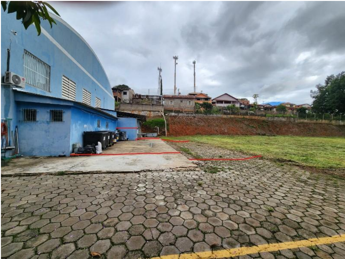
Figura 3 - Vista do local de implantação do novo bloco
