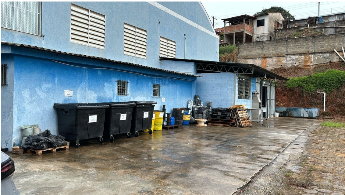
Figura 2 - vista da parte dos fundos do prédio existente
